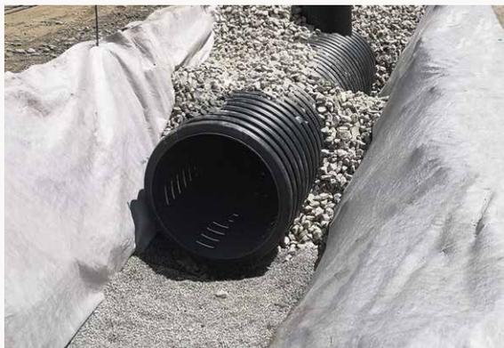
Installation d'un ouvrage de rétention et d'infiltration permettant une gestion des eaux pluviales à la parcelle. L'objectif étant de retrouver le cycle naturel de l'eau.
