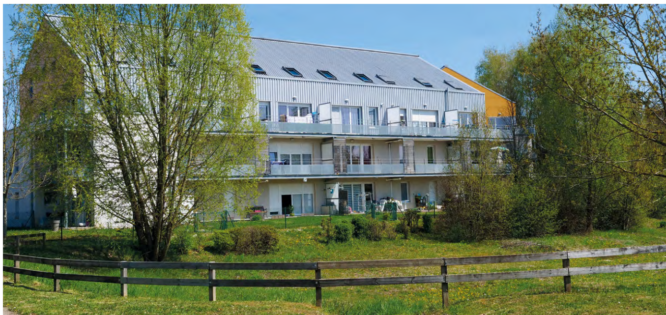
Bassin de rétention d'eau – Hauts de Bavans
